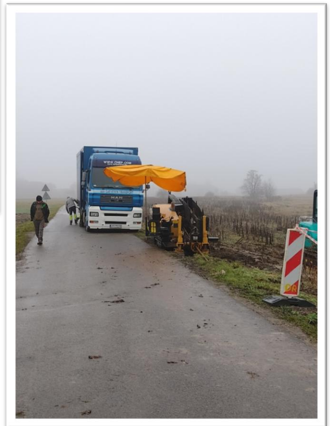
Praca wiertnicy przy budowanym wodociągu.
