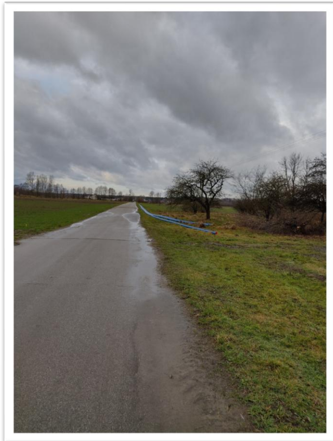
Sklejone odcinki rur wodociągu czekają na wbudowanie.
