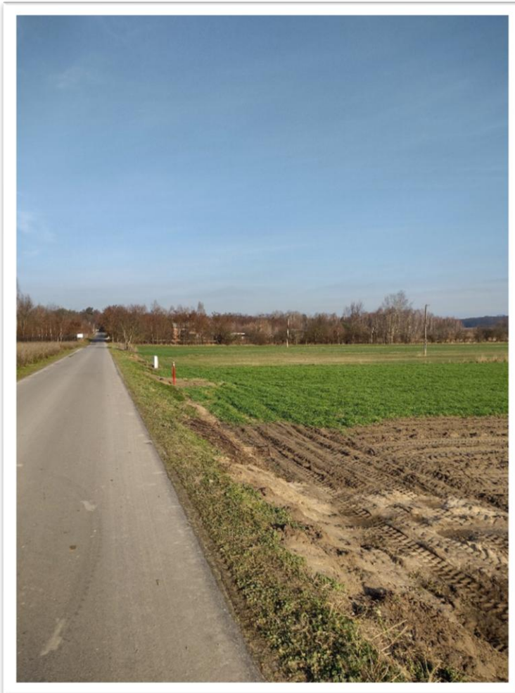
Odcinek nowo wybudowanego wodociągu w miejscowości Sobieszyn
