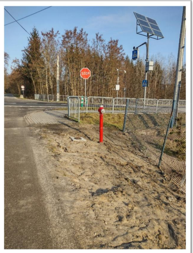
Widok skrzyżowania z drogą krajową K 48 oraz zakończenie wodociągu hydrantem.
